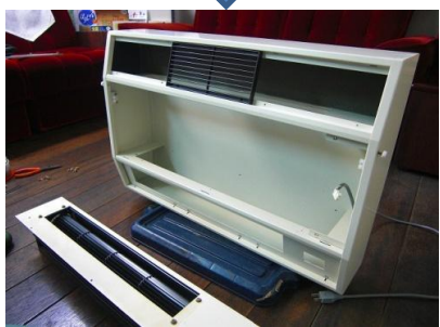
取り外し完了
