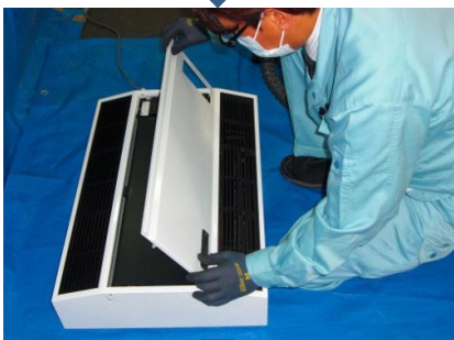
フロントパネルを 外します 外した後掃除機を かけておきます
