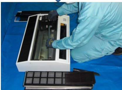
殺菌灯カバーを 拭き上げた後、 取り付けます
