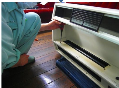
背面の3本の小さいネジを外します 右側
