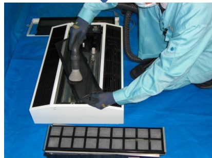
プレフィルターの ほこりを掃除機で 吸入しておきます
