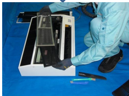
プレフィルターと 電弱フィルター を重ねます 電弱フィルターの 中央フレームが手前 に来るように
