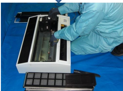
殺菌灯、点灯管 を取り付けます
