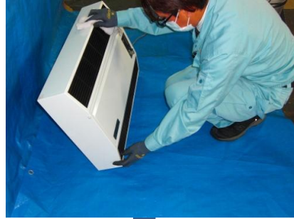
拭き上げ完了後動作確認を行います
