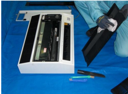
内部パネルを拭き上げます
