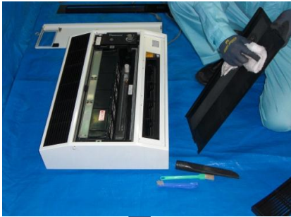
内部パネルを拭き上げます
