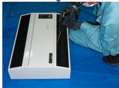
下部ルーバーを取り付けます
