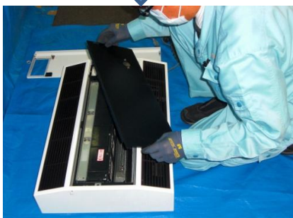
内部パネルを 外します 外した後掃除機を かけておきます
