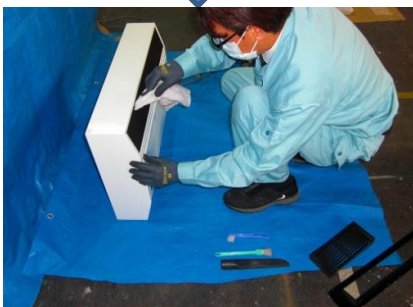
上部ルーバーを プラスチックドライバーと タオルで拭き上げます
