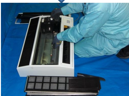
殺菌灯、点灯管 を取り付けます
