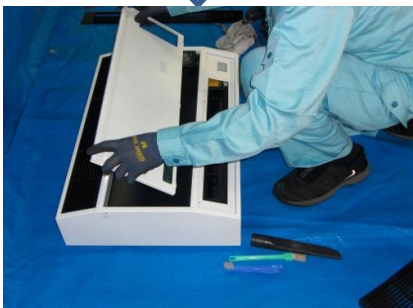
フロントパネルを取り付けます
