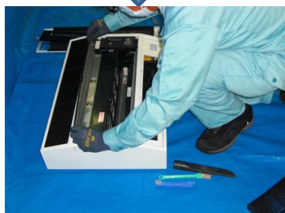
プレフィルターと 電弱フィルターを 同時に取り付けます
